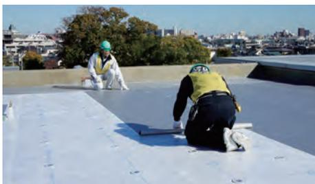
塩化ビニル樹脂系のシートを接着剤を用いて下地に貼り付ける接着工法、または下地にアンカーを打ち込み機械的に防水を固定する工法があります。単層のシート防水ですが、熱や溶剤で溶ける塩ビ樹脂の特性によりシート同士を溶融着して一体化できるため、水密性の高い防水層を形成します。
