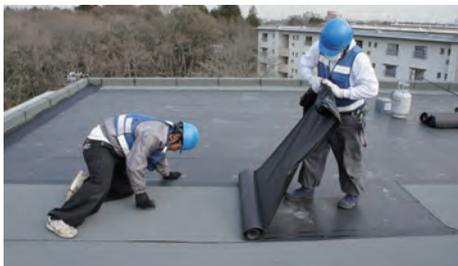
従来のアスファルト防水の耐久性・柔軟性を向上した、「改質アスファルト」を主原料とするシートで、裏面のゴムアスファルト粘着材で下地に貼り付けます。アスファルト・コンクリート・ウレタン・シートなど、さまざまな下地と相性が良く、火気を使わずに改修工事ができる、クリーンかつ安心の防水改修工法です。
