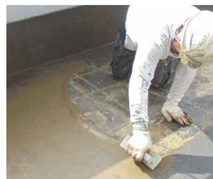
既存防水層を撤去後、新たにアスファルト系防水を施工するまでの一時的な仮防水として用います。この上にはプライマーなしでアスファルト系工法の施工が可能です。
