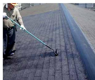
勾配屋根で使用するのに適した粘度に配合された既存シングル屋根用下地調整材です。かぶせ改修を可能にします。
