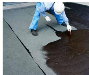
既存アスファルト系防水層の部分撤去後の穴埋めや、不陸調整などに適している水性ゴムアスファルト系下地処理材です。既存砂付ルーフィング全面に施工することもできます。
