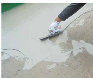
既存防水層を撤去後、新たに防水を施工するまでの一時的な仮防水として用います。特に高分子系新規防水に適しています。コンクリート下地にも適用可能です。
