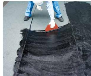
既存アスファルト防水面を活性化させるアスファルト系下地処理材です。同種のアスファルト系防水にかぶせ改修を可能にします。
