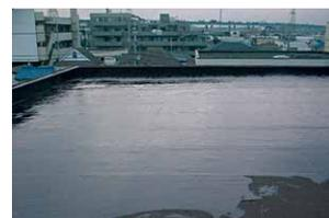
**適用下地** 既存露出アスファルト防水面下地
