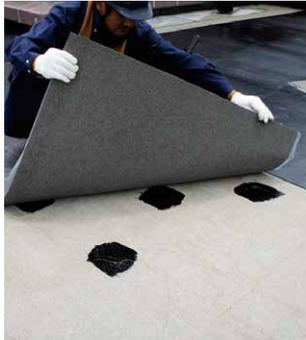
膨れ・脆弱部の多い露出アスファルト防水面の乾式下地処理
