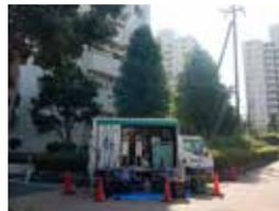
OSSシステム搭載トラックは地上に配備。屋上に直接伸ばしたホースで材料を強力圧送します。
