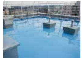
施工時の最低気温は23℃でしたが硬化性は良好で、14:00には2層目の施工が完了しました。
